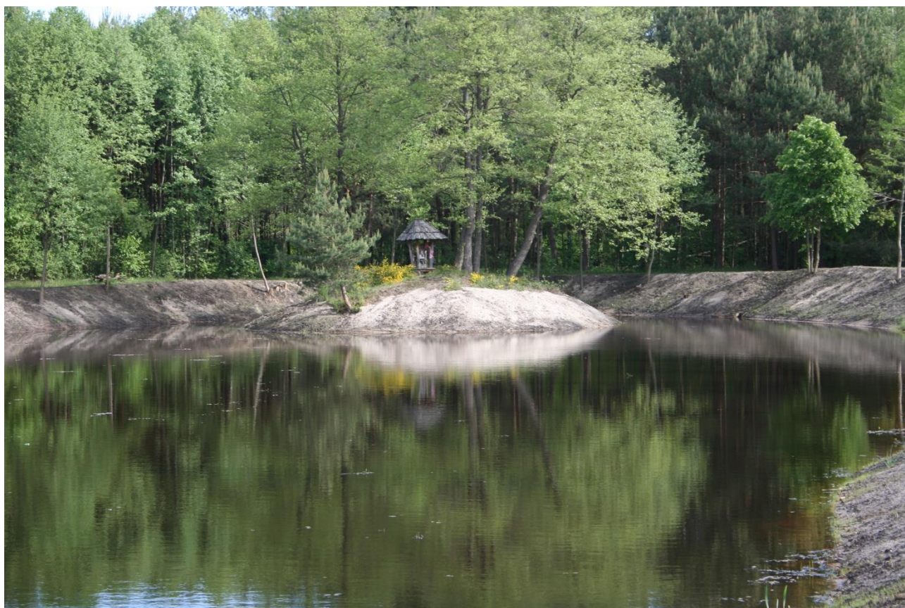
Zbiornik po rewitalizacji
